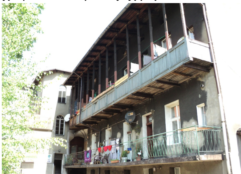
Zdjęcie 2. Zdjęcie przedstawia budynek znajdujący się w obszarze rewitalizacji nr 1
