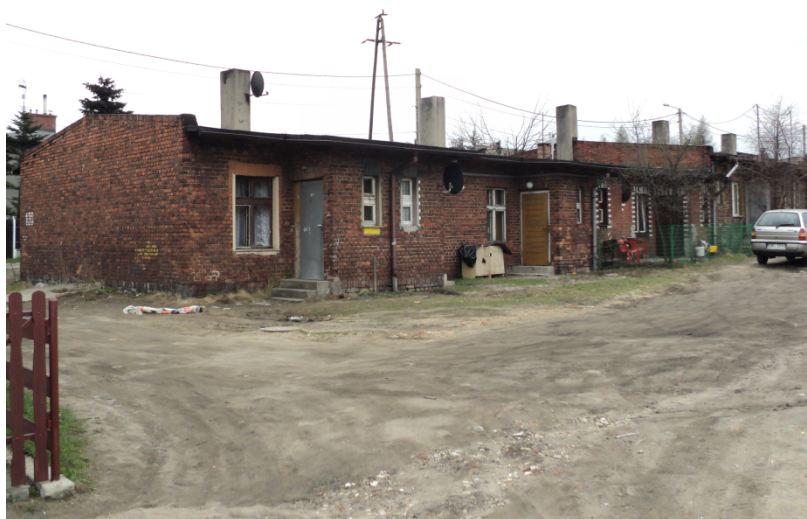
Zdjęcie 4. Zdjęcie przedstawia budynek mieszkalny znajdujący się w obszarze rewitalizacji nr 2
