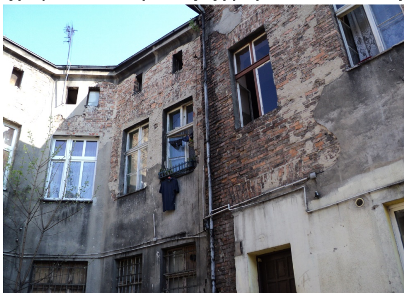
Zdjęcie 1. Zdjęcie przedstawia budynek znajdujący się w obszarze rewitalizacji nr 1
